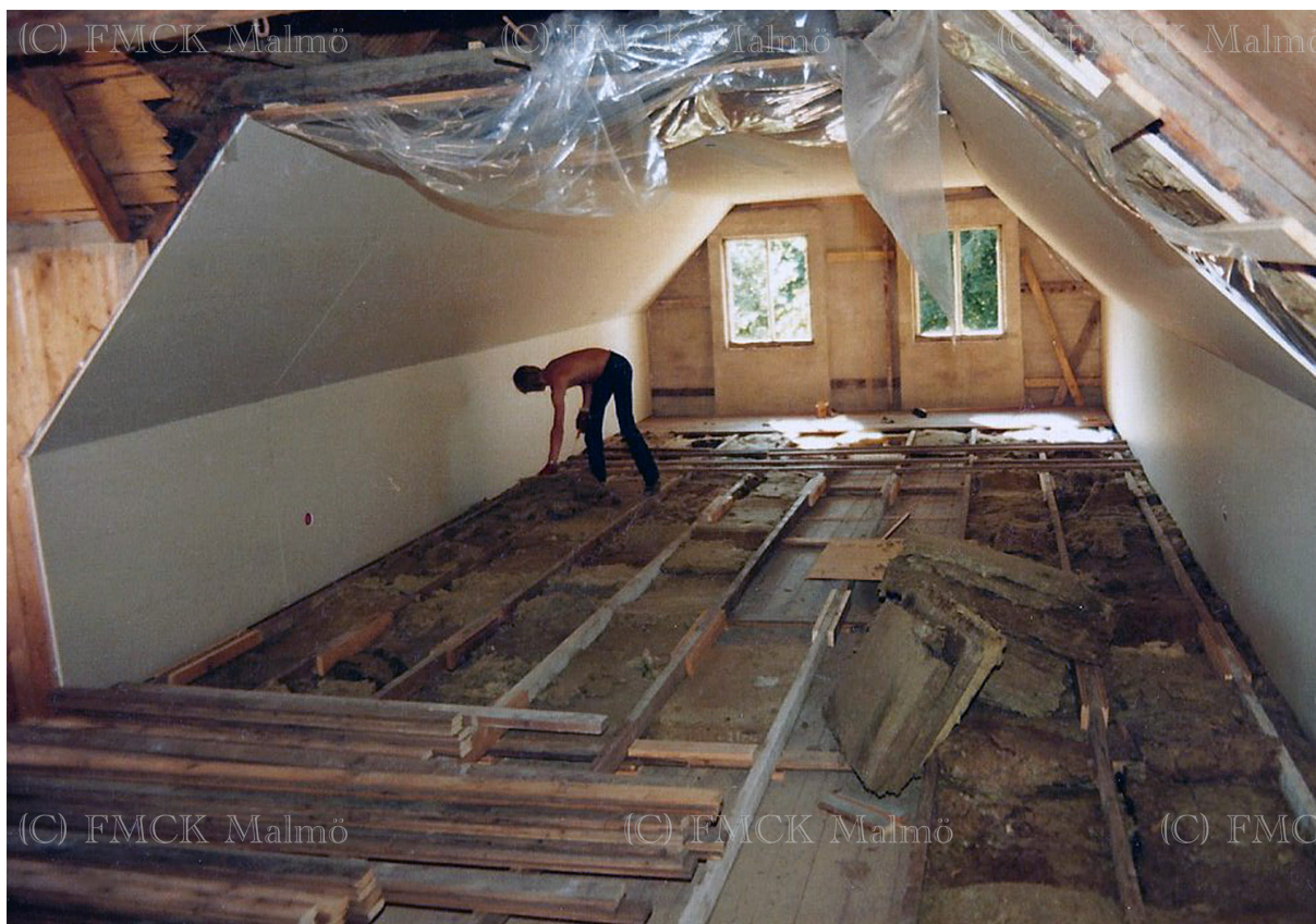
Vinden inreddes och isolerades. Här blir det snart en lektionssal
